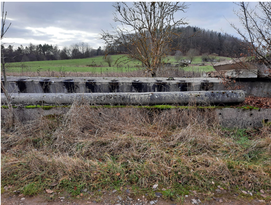
Foto: Vorhandene Betonablagerungen auf der Deponiefläche
