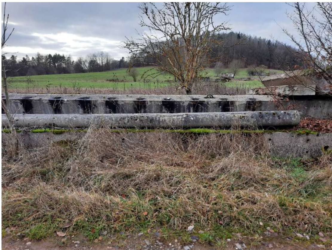
Foto: Vorhandene Betonablagerungen auf der Haldenfläche
